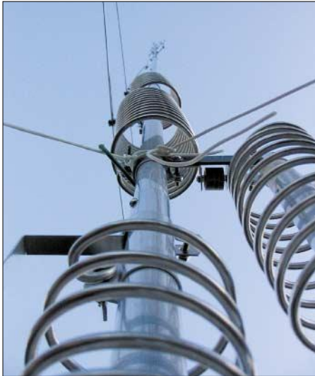
Bild 7: Gesamtansicht der HF9V von unten
